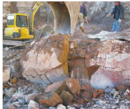
1,0 mm/sec. l'ambito prevalente dell'azione meccanica del mezzo escavatore e al di sopra l'ambito degli interventi con cartucce Nonex che evidenzia un trend medio pari a 5,0 mm/sec. con valori di frequenza superiori a 100 Hz.
